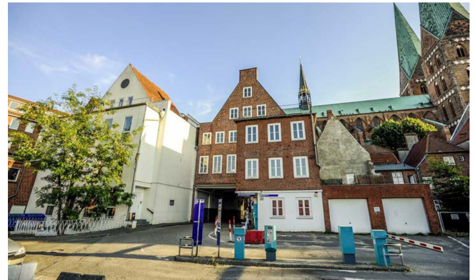
Abb. 3.1.2f: Blick auf die hofseitigen Fassaden
