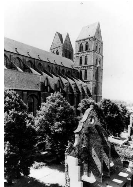
Abb. 3.1.1.j: Blick hinter die abgestützte Fassade
